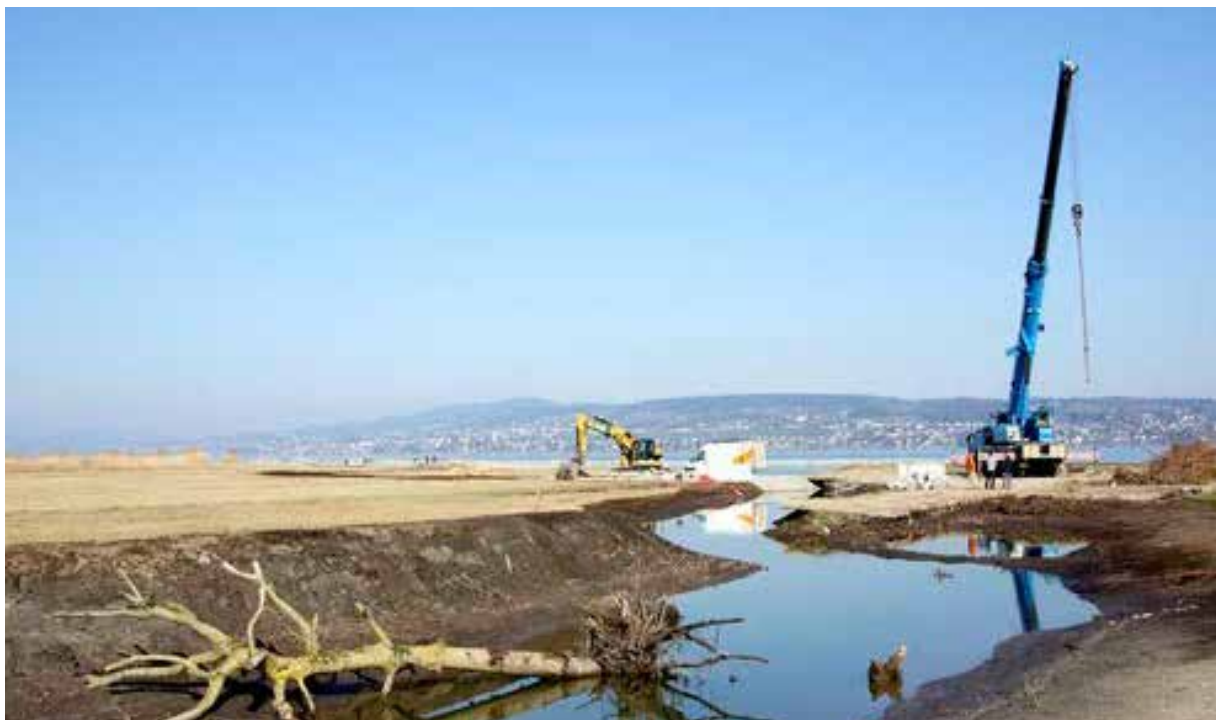
Die Arbeiten am Projekt Pfäffiker Ried II am Frauenwinkel SZ.
