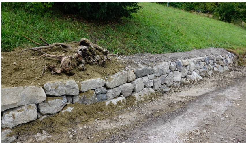
III. 8 : Mur en pierres sèches à Maur (ZH)
