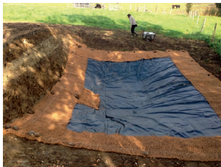
Zum Abdichten wird die Grube mit einer Folie belegt.
