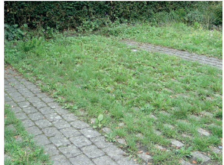
Parkplatz mit durchlässigem Belag
