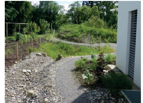
Regenwasserableitung entlang eines Weges in eine Feuchtmulde.
