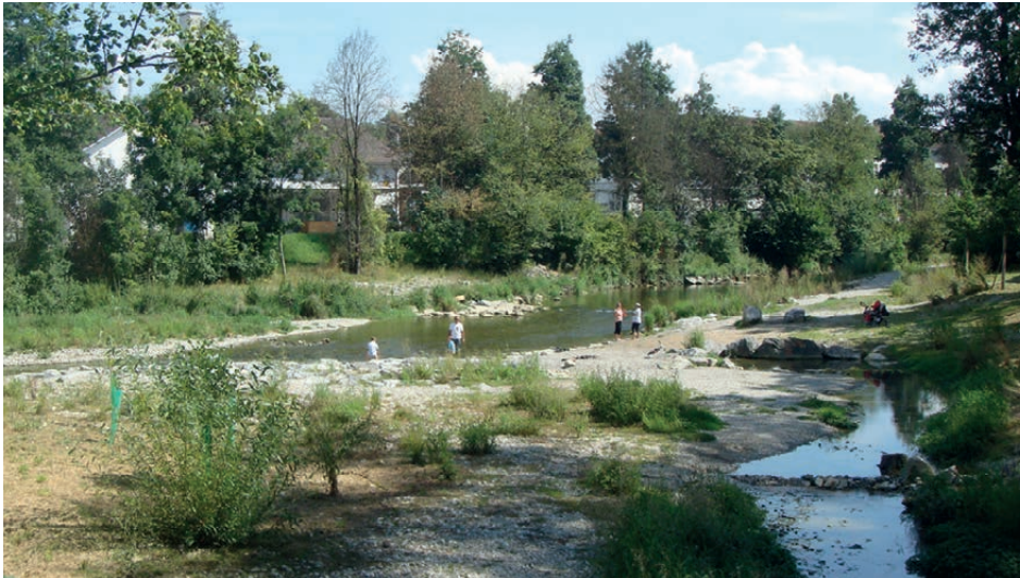
Die revitalisierte Murg bei Frauenfeld wurde bewusst als Teil eines Parkes gestaltet. Dafür sind Elemente der Allmend an der Thur Naturvorranggebiete.
