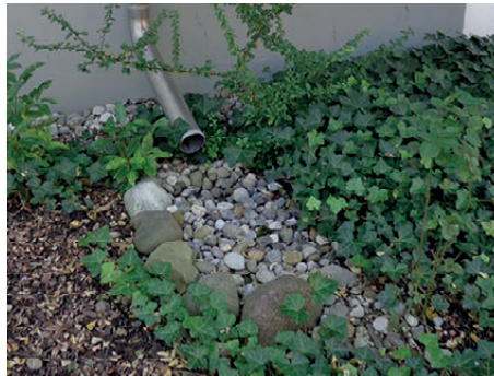
Versickerung des Regenwassers. Steine verhindern ein Wegschwemmen der Erde.
