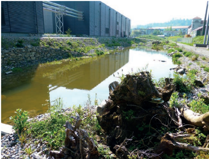
Naturnaher Versickerungsteich bei einem Gewerbebau.
