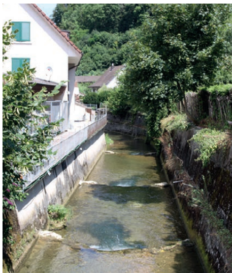
Entlang kanalisierter Bäche können keine Landlebtiere den Siedlungsraum durchqueren.
