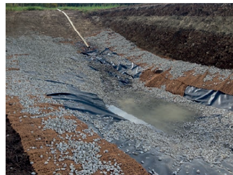
Die Folie wird mit Wandkies abgedeckt.
