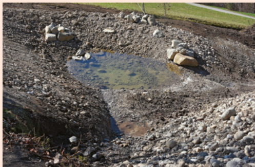
Vogelherd: neuer Lebensraum für die Geburtshelferkröte entlang des Ziegelhüttenbaches während der Erstellung am 21. März 2019 und im fertigen Zustand am 24. März 2019.
