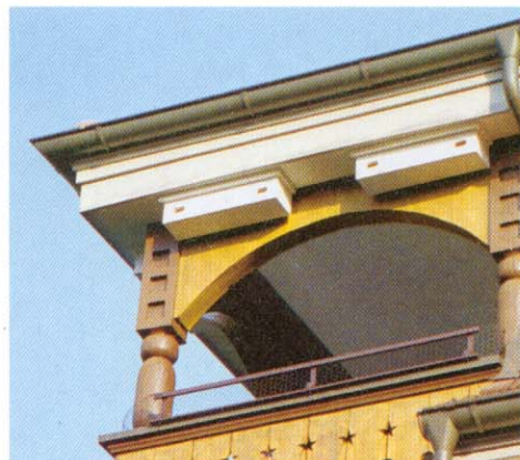
Unterteilte Doppelkästen mit seitlichen Einfluglöchern. Die Einflüge liegen beim Kastenende, weil Mauersegler zum Brüten eine dunkle Kastenhälfte schätzen.
