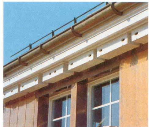
Nistkästen als Ersatz für Brutplätze, die bei der Dachrenovation verloren gingen.
