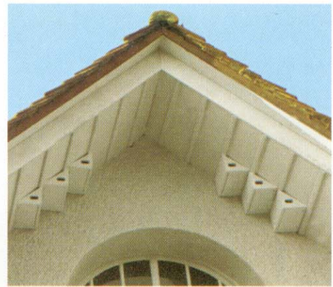
Als Anpassung an die schräge Dachunterseite wurden hier Dreieckskästen verwendet. Sie lassen sich seitlich öffnen und vom Fenster aus warten.
