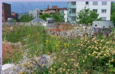
Flachdächer sowie Dächer aller Art mit einer Neigung unter 8 Grad eignen sich hervorragend für eine Begrünung. Doch sind auch Begrünungen bei Dachneigungen bis zu 45 Grad möglich, wenn spezielle Schubsicherungen gegen das Abrutschen eingebaut werden.
