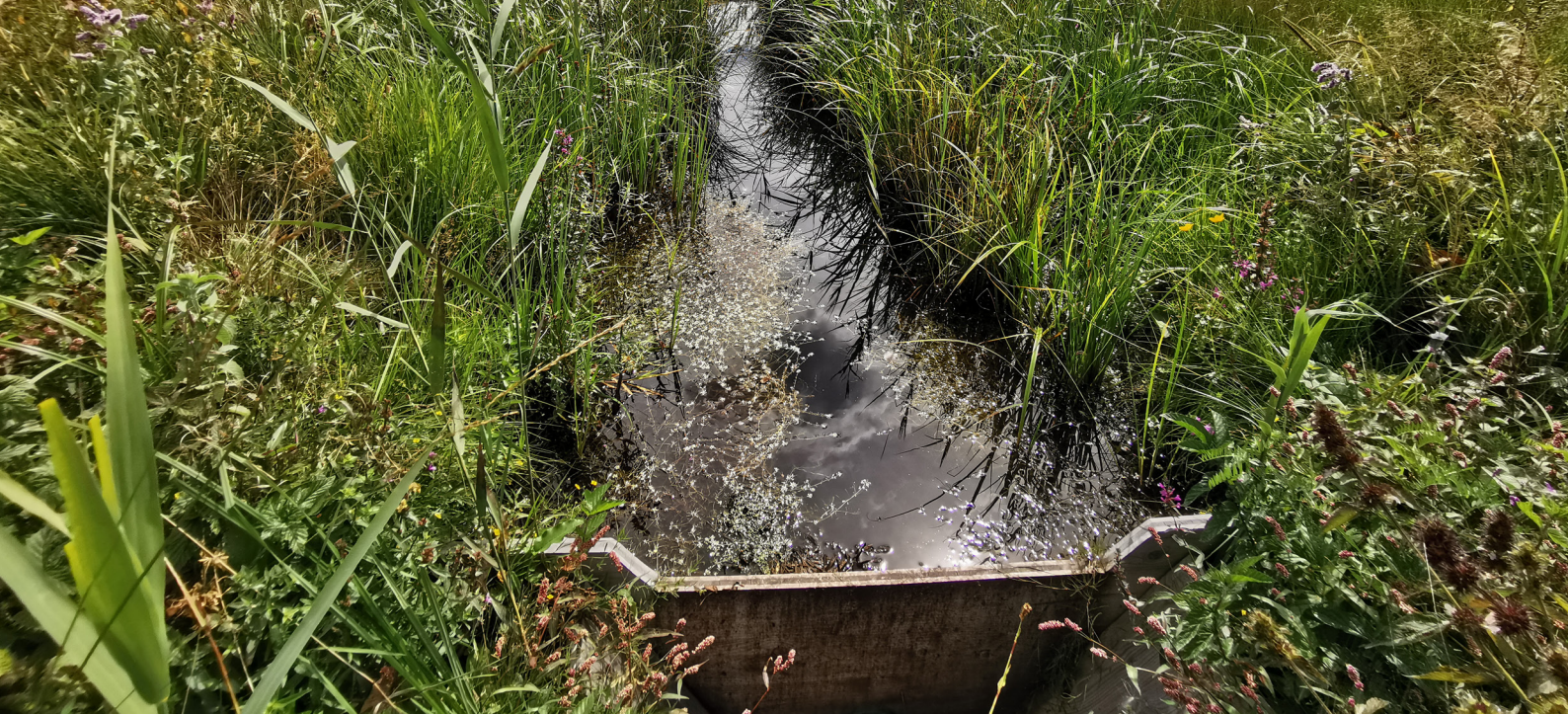
Retenue sur un canal de drainage dans le marais de Rothenthurm.
