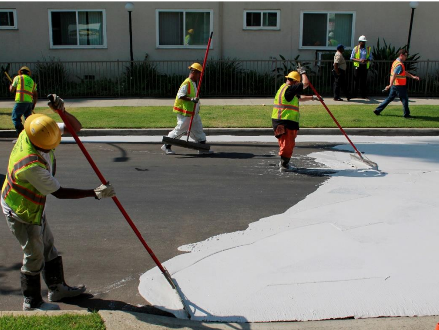
Hitzereduktion über einen reflektierenden Strassenanstrich – «Coole Pavement» im Los Angeles
