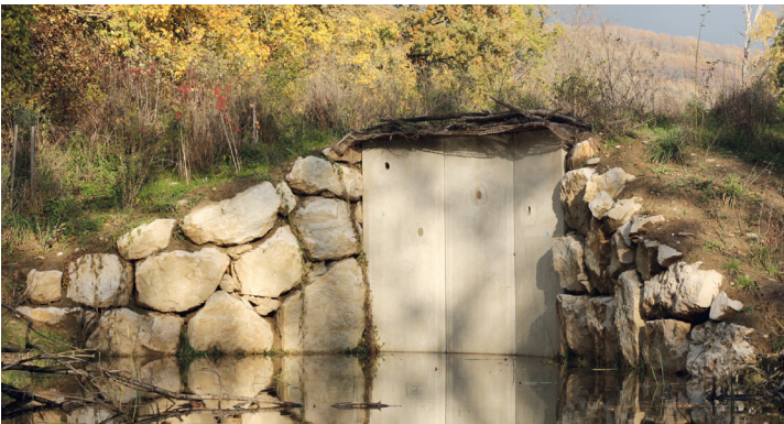
Es gibt verschiedene Varianten, eine künstliche Brutwand für den Eisvogel zu schaffen. In der Betonwand sind Öffnungen für Brutröhren des Eisvogels zu sehen. Il existe plusieurs variantes de parois de nidification artificielles pour le Martin-pêcheur. Cette paroi en béton arbore des trous pour ses galeries de nidification. Foto: BirdLife Naturzentrum Klingnauer Stausee
