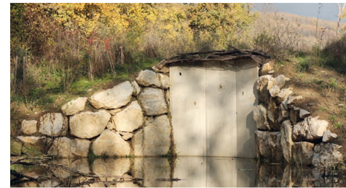
Es gibt verschiedene Varianten, eine künstliche Brutwand für den Eisvogel zu schaffen. In der Betonwand sind Öffnungen für Brutröhren des Eisvogels zu sehen. Esistono diverse varianti di pareti artificiali per la nidificazione del Martin pescatore. Questa parete in cemento presenta dei fori che fungono da gallerie per la nidificazione. Foto: Centro natura BirdLife Klingnauer Stausee
