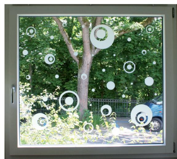
Planification avant la construction: un verre imprimé rend l'obstacle visible pour les oiseaux.
