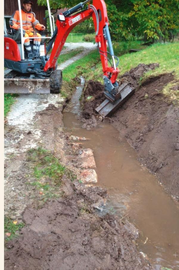
*Der eingewachsene Bachabschnitt (links) wird durch den Baggereinsatz ausgeweitet (oben).*
