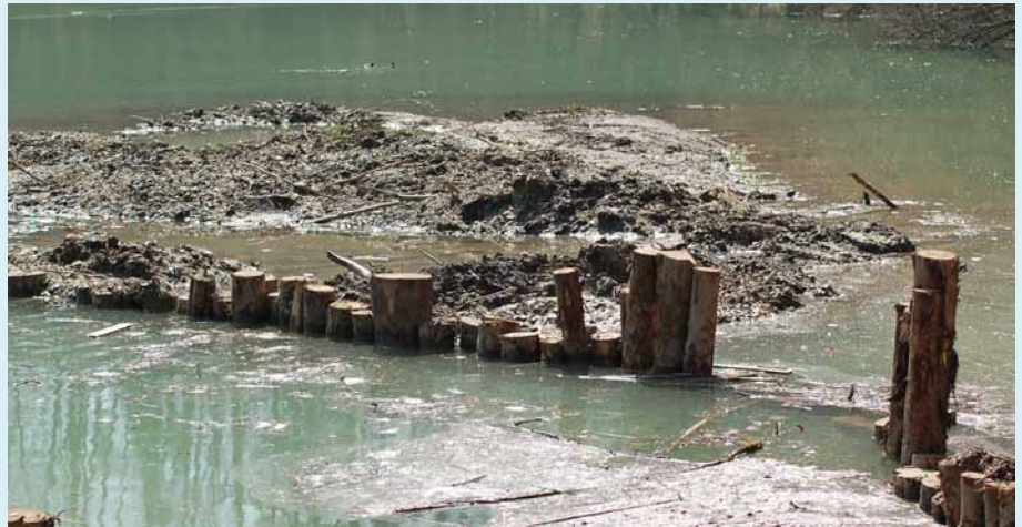
Hier entsteht die erweiterte Verhandlungszone. Ein weiterer Realisierungsschritt in der Entwicklung vom Stauteich zu einem ökologisch wertvollen Kleingewässer.
