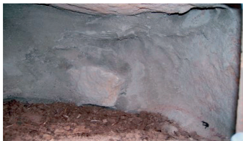
Fig. 8: interno cementato. Importante: l'acqua deve poter colare e non inondare la cavità.
