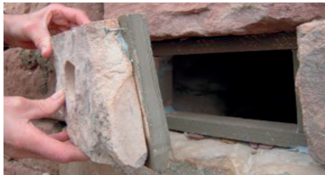
Fig. 9: gli angoli delle pietre di copertura sono tagliati per poter piazzare le viti.
