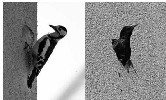
Fig. 1: Pic épeiche et son trou sur une façade à isolation extérieure (R. Oeschger)
