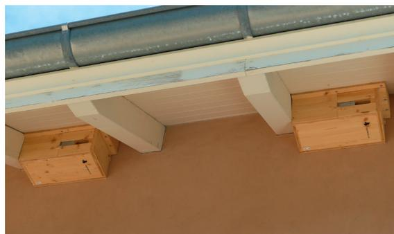
*Illustration 2 : Nichoir à martinet noir typique, avec système de fermeture. Le trou d'entrée peut être pratiqué sur le long côté (comme sur la photo) ou sur le côté court (Photo : Hans Schmid).*
